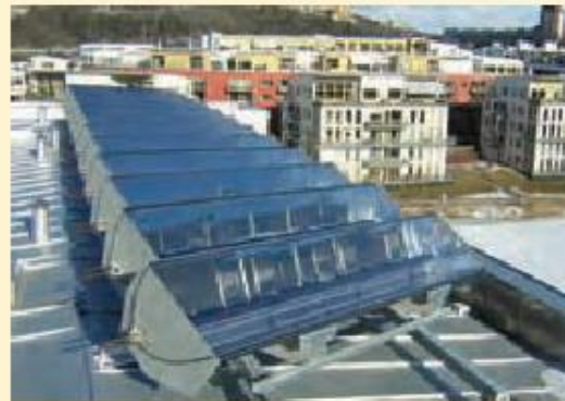
stationary module (Vattenfall)
